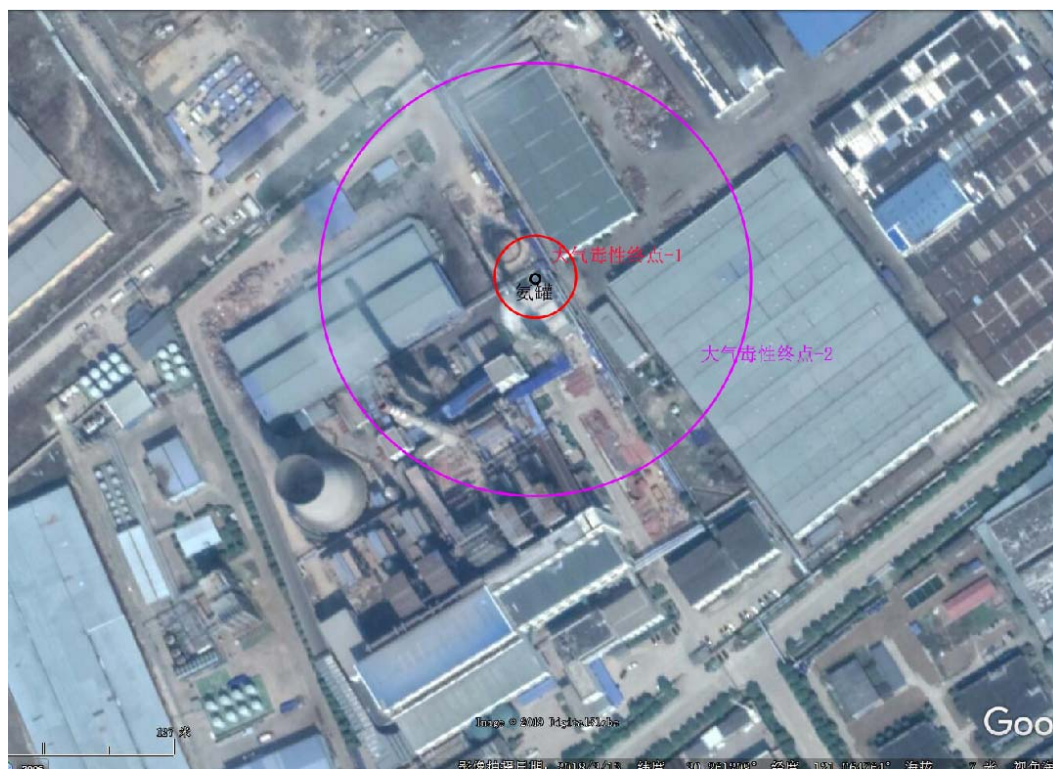
图 6.8-2 氨罐泄漏大气影响范围图
